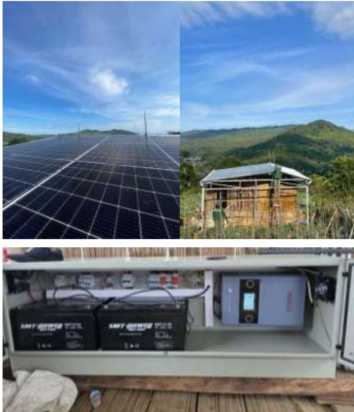
Gambar 9. Rangkaian dan Struktur Panel Surya PLTS Atap
